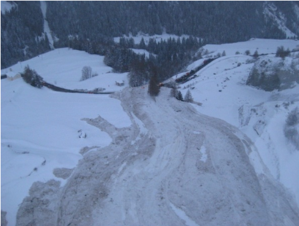
Photo 1: Avalanche spontanée qui s'est déclenchée au-dessus de Torrent d'Aron à environ 2500 m sur une pente exposée au nord-est et qui a atteint une grande ampleur. La route du col du Grand-St-Bernard a été ensevelie près de Liddes, (VS) sur une largeur d'environ 40 m (Photo : E. Berclaz 6.03.2009).
