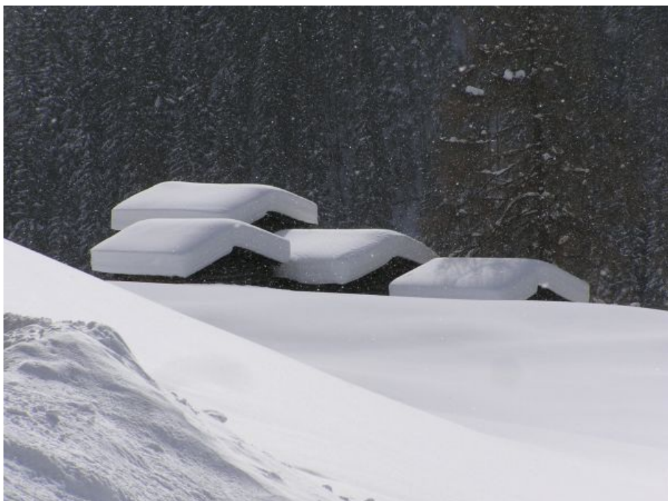
Photo 7: Paysage avec une épaisse couche de neige dans la région de Davos et d'énormes charges sur les toits des vieilles constructions en madriers près de Monstein (photo: SLF/C.Pielmeier, 18.02.2009)
