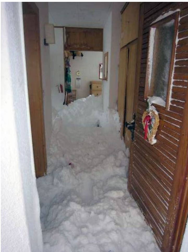
Photo 10: Le vendredi 23 janvier, une avalanche a touché trois maisons de vacances à la sortie du village de Bivio. Personne n'a été blessé, mais il y a eu des dégâts matériels. L'avalanche s'est décrochée sur une pente exposée au sud-ouest à environ 1970 m et a touché les maisons exposées (photo: Police cantonale GR).
