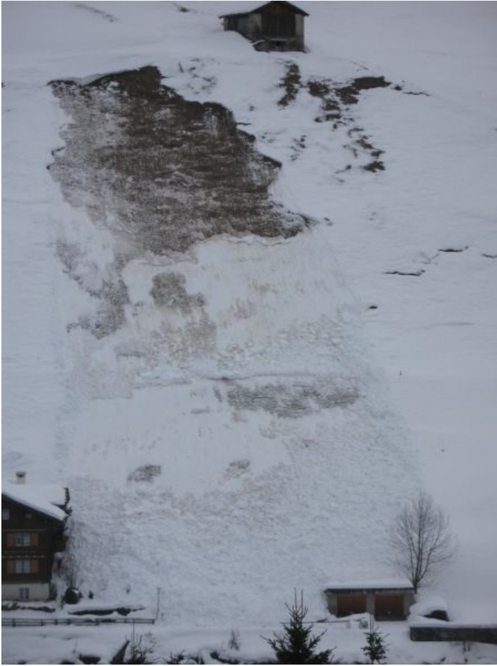
Diese Gleitschneelawine beschädigte einen Balkon in Vals, GR (Foto: H. Tönz, 15.12.2008)
