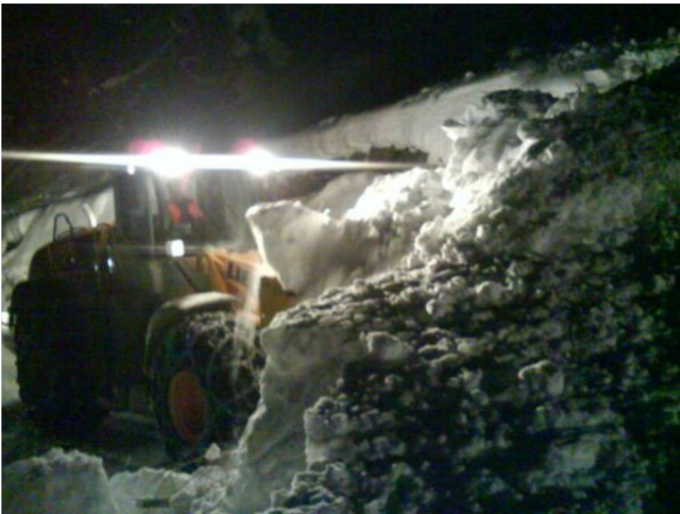
Lawinenträumung nach einem Lawinenabgang im "Laviner dal Sprudà" auf der Ofenpassstrasse oberhalb von Zernez, GR (Foto: J. Kindschi, 14.12.2008)
