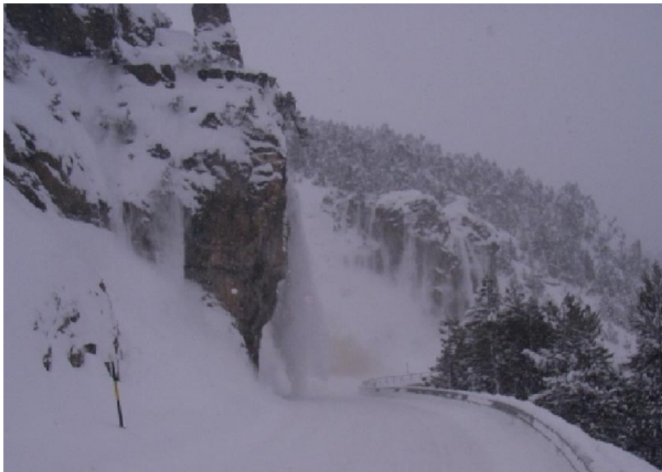
Photo 2: Opération de sécurisation à l'Ofenpass (GR). Une avalanche déclenchée par minage déferle précisément sur la route fermée (photo: P. Caviezel, 1.12.2008).
