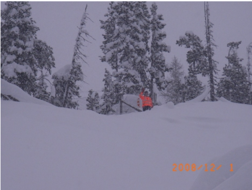
Arbeiter im tiefsten Winter: Lawinensprengung an der Ofenpassstrasse, GR (Foto: P.Caviezel, 1.12.2008).
