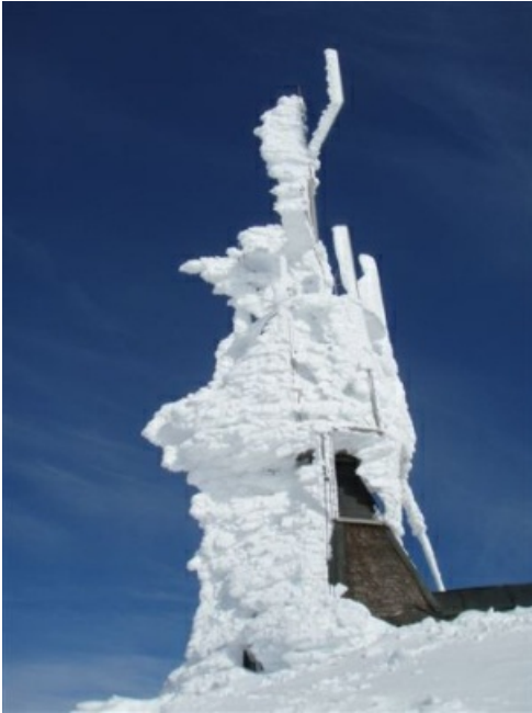
Das alte Windmesserhäuschen auf dem Säntis ist komplett vom Raureif zugekleistert. Hoffen wir, dass es den modernen Messgeräten besser ergangen ist! Raureif entsteht bei Nebel, wenn der Wind unterkühlte Wassertröpfchen auf ein Hindernis schleudert. Raureif wächst gegen den Wind, d.h. der Wind blies auf dem Bild von links nach rechts (Foto: P. Diener, 19.03.2008).
