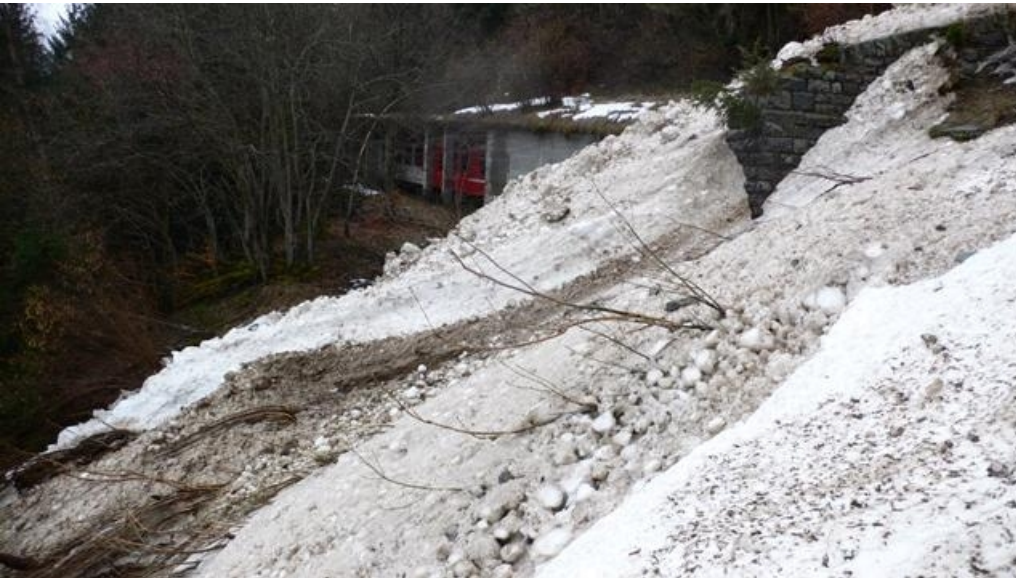
Couloir du l'avanché à la hauteur de la protection de la voix de chemin de fer du Martigny-Chamonix 1100 m, elle est descendue le vendredi 2 mars dans la nuit (J.L. Lugon, 03.03.2007).
