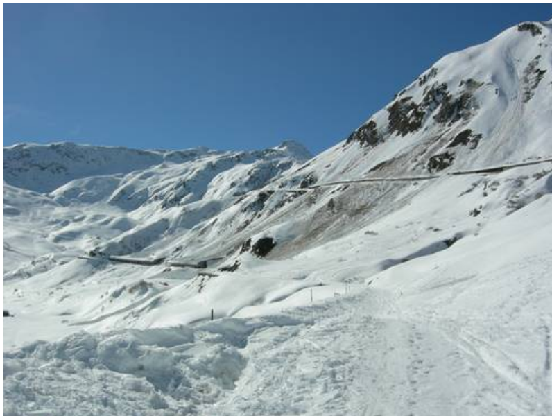
Photo 14: Cette grande avalanche de neige humide a franchi la galerie du chemin de fer Cervin-Gothard et la route fermée du col de l'Oberalp (GR). Exposition sud-est, rupture à environ 2050 m dans une zone raide rocheuse (photo: P. de Werra, 19.03.2006).
