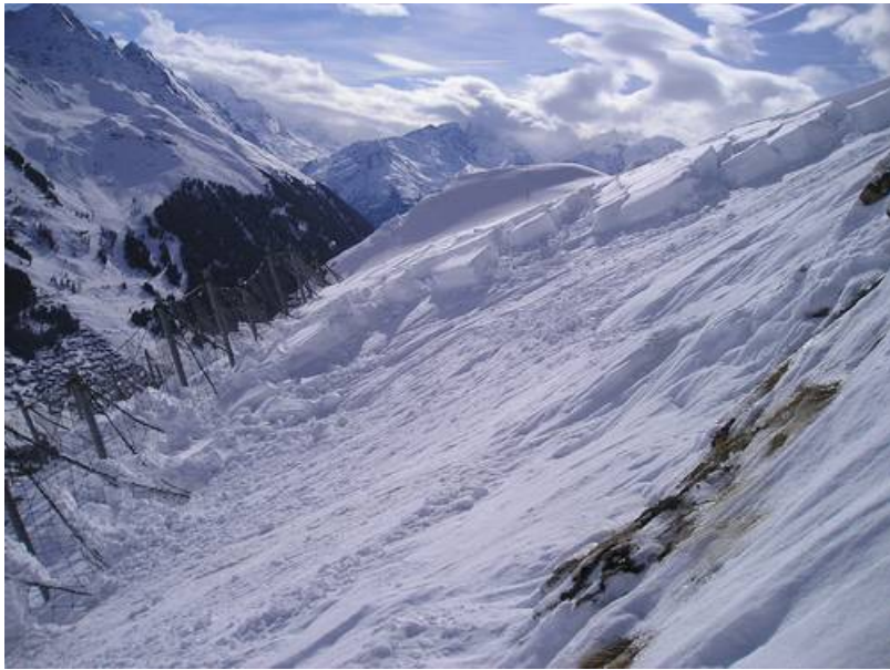
Photo 11: Avalanche de plaque de neige déclenchée spontanément le 20 février dans les constructions paravalanches sur une pente exposée à l'est à environ 2200 m. La Tournelle, Verbier, VS (photo: M. Maret, 21.02.2006).
