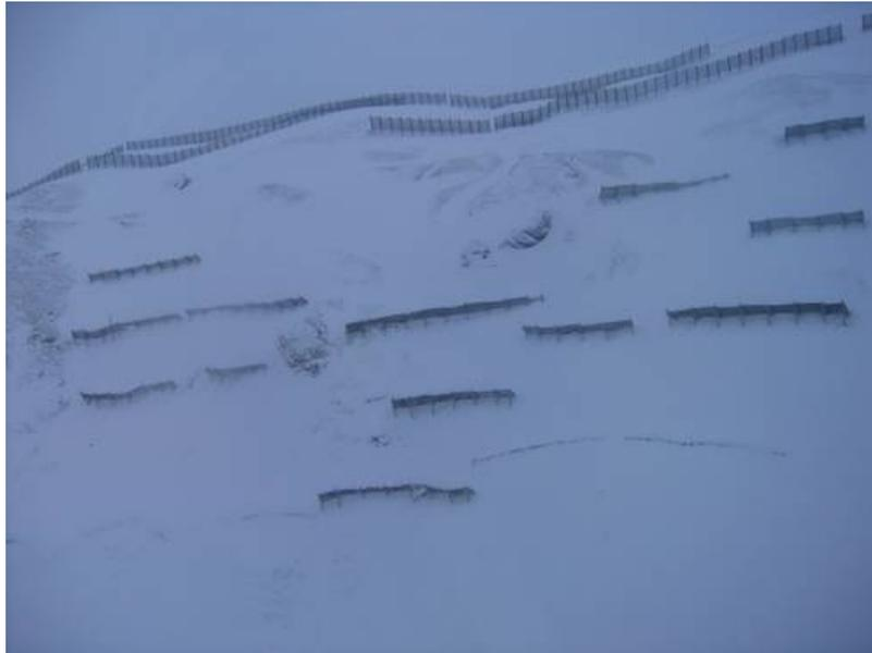
*Photo 12: Cette avalanche s'est décrochée dans les ouvrages paravalanches au Muot da l'Hom au-dessus de Ftan en Basse-Engadine (GR) et a endommagé le dispositif de protection. L'ouvrage avait toutefois déjà été fragilisé par le glissement de la pente (photo: J. Kindschi, 19.12.2005).*
