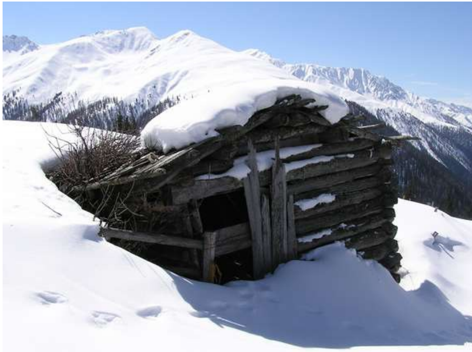
Abb. 3: Grosse Schneemengen zwangen schon so manches, mehr oder weniger "modernes" Gebäude in die Knie (Foto: SLF/C. Pielmeier, 30.03.2004).
