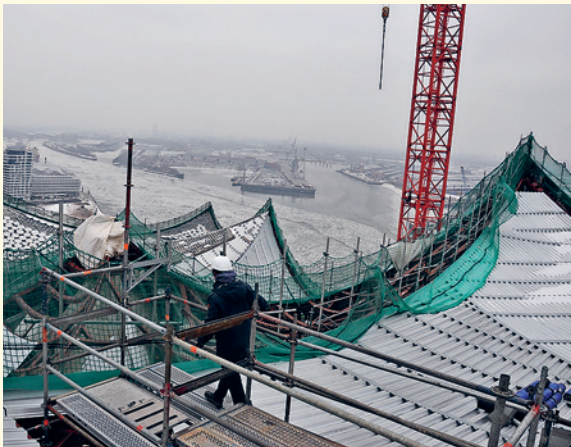
Das Dach der Elbphilharmonie ist bis zu 50° steil. Dank den richtigen Materialien können Dachlawinen verhindert werden.
