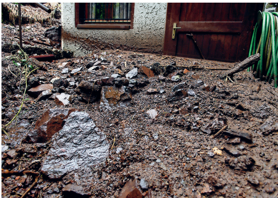
Extrem für die Betroffenen: Heftige Niederschläge haben am 29. August 2020 in Bissone (TI) einen Murgang ausgelöst, Schlamm und Geröll haben Häuser beschädigt.
