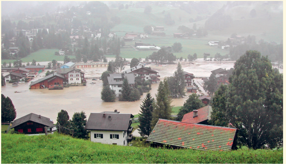
Bei verheerenden Überschwemmungen wurden im Jahr 2005 viele Gebäude beschädigt, wie hier in Klosters (GR).
