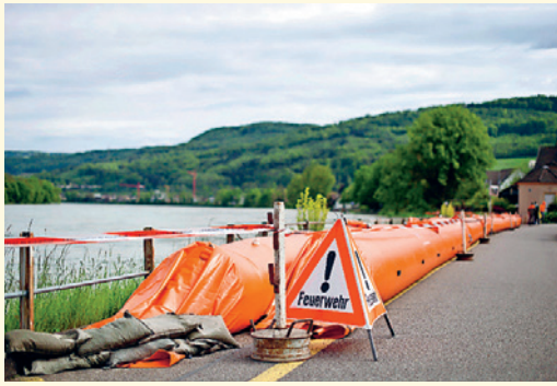
Dank frühzeitiger Warnung können geeignete Massnahmen ergriffen und Schäden vermieden werden.
