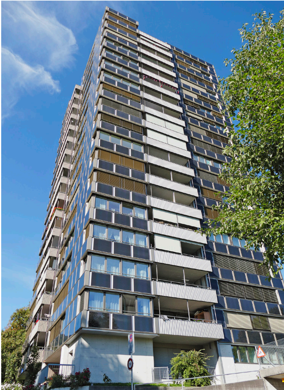
Die Fotovoltaik-Fassade dieses Hochhauses in Zürich Leimbach liefert rund 85 000 kWh pro Jahr und deckt so einen Drittel des Stroms, den die Bewohner konsumieren.
