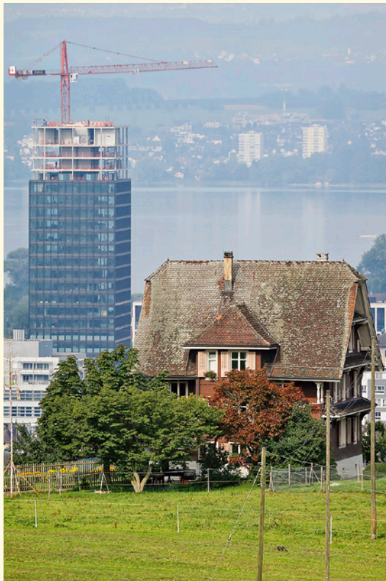
Bauarbeiten am höchsten Gebäude im Kanton Zug, dem Park-Tower.
