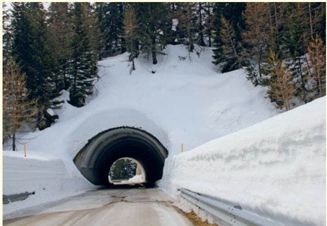
Von einer steilen Fläche über einem Tunnelportal kann Schnee auf die Strasse rutschen, so wie hier am Lukmanierpass.
