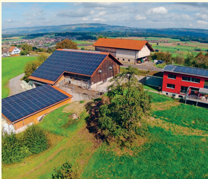
Fotovoltaikanlage auf der Dachfläche eines Landwirtschaftsbetriebs in Kallern (AG).
