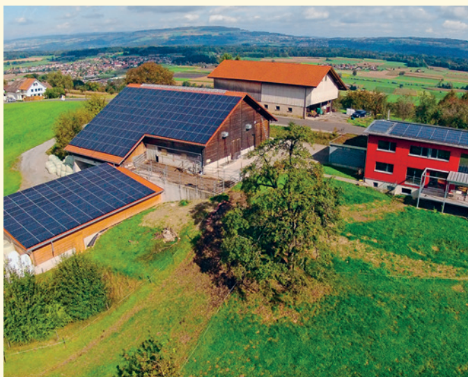
Installation photovoltaïque sur les toits d'une exploitation agricole à Kallern (AG).
