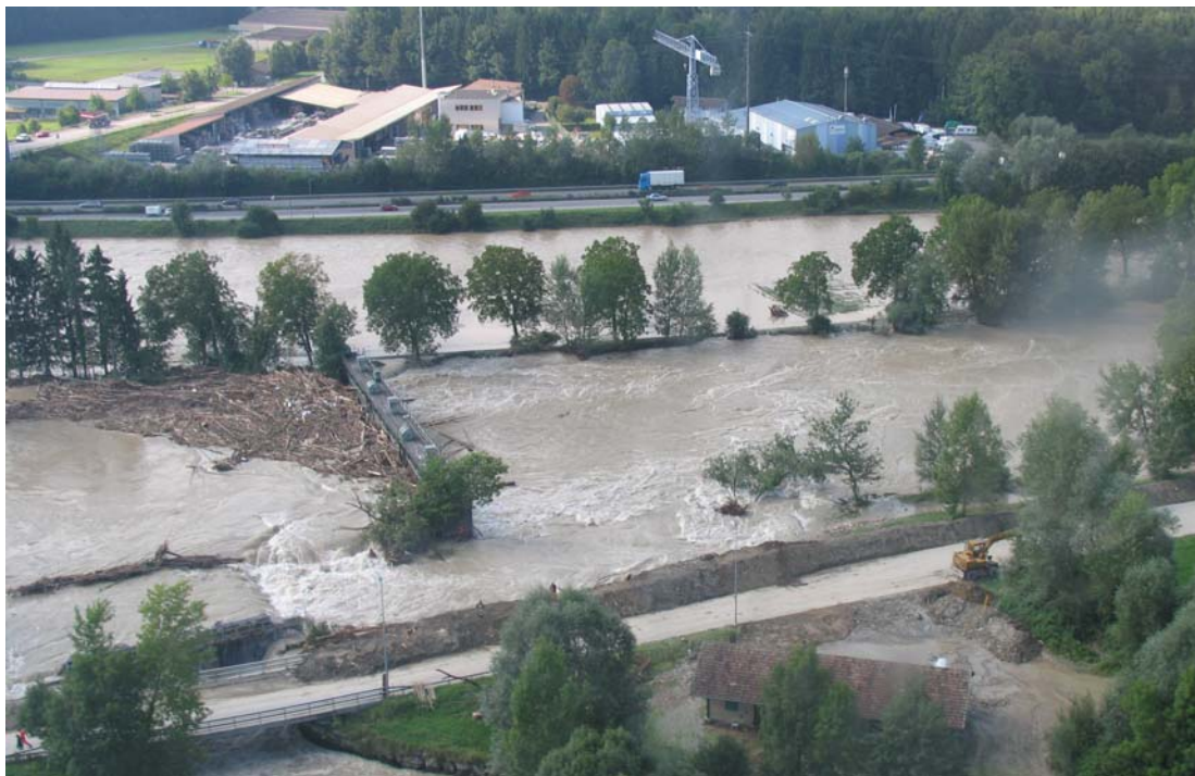
Abb. 2.2. Verklausung am Wehr des Kraftwerkes Perlen/Buchrain, LU im August 2005.
