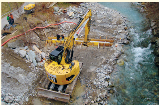
Diesen Frühling wurde in der Albula bei Tiefencastel eine neue Geschiebemessanlage gebaut.
