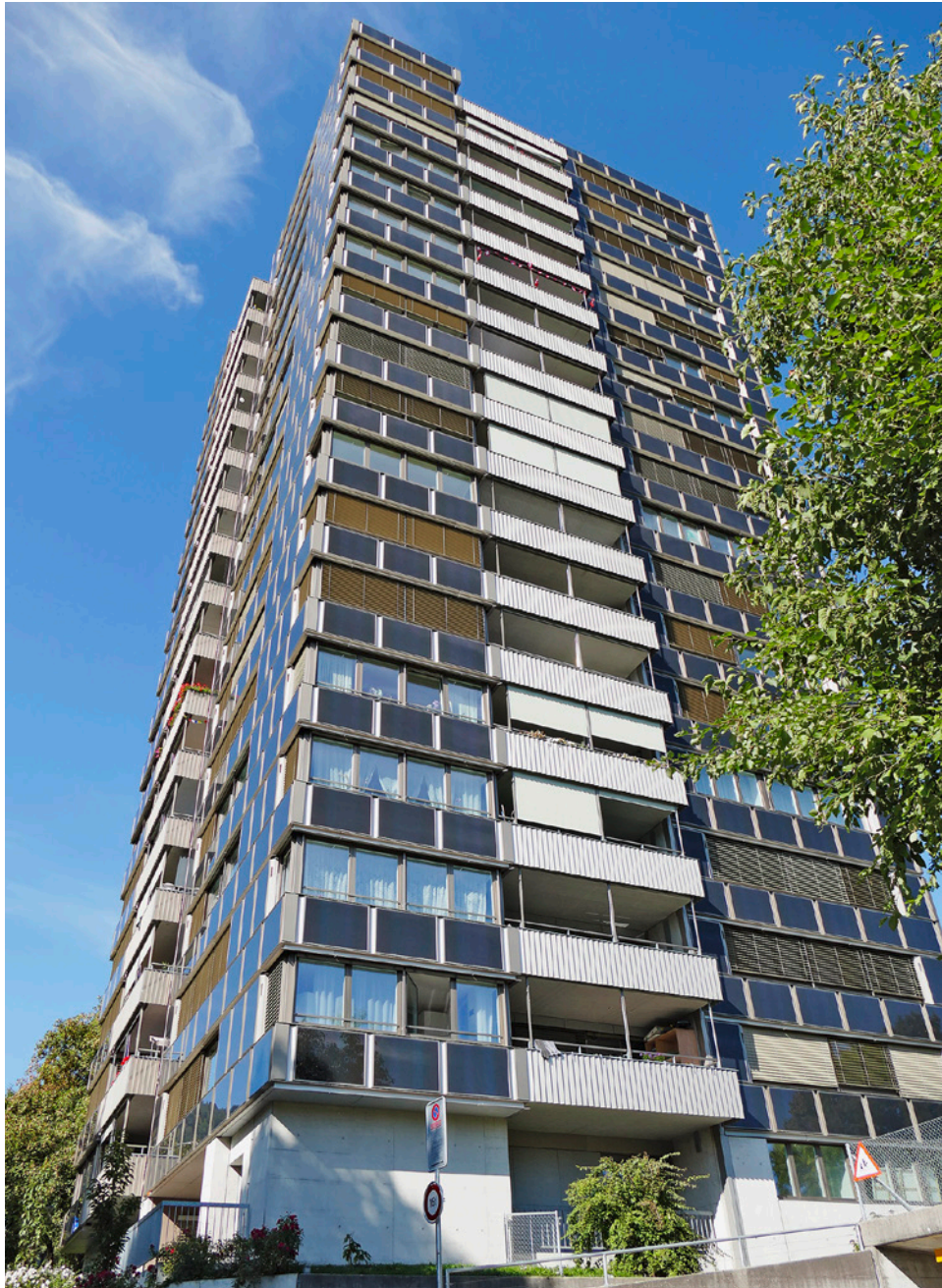
La façade photovoltaïque de cette tour à Zurich Leimbach fournit environ 85 000 kWh/an et couvre ainsi un tiers de l'électricité consommée par les habitants.
