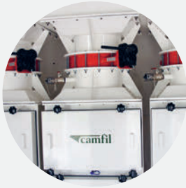
L'installation à double filtrage garantit un air sortant aseptique.
