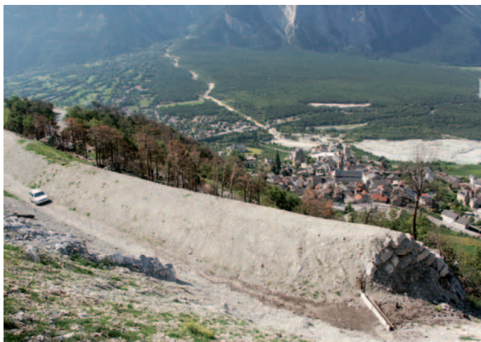
Abb. 7. Zwei Dämme mit Wirkhöhen von 3 m wurden zum Schutz von Leuk-Stadt und der Kantonsstrasse Leuk-Leukerbad erstellt.
