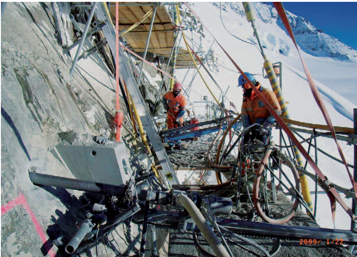
Fig. 38: Lavori di ancoraggio nella roccia per proteggere l'uscita di una galleria dalla caduta di massi (foto: Gasser, Lungern).
