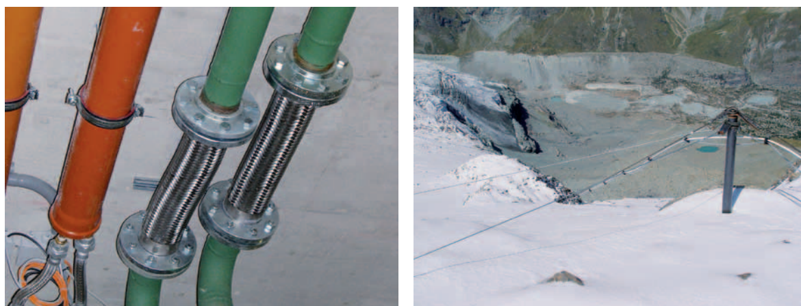
Fig. 51: Due esempi di conduitture di acqua flessibili; (a sinistra) raccordo flessibile utilizzabile all'interno di un edificio; (a destra) conduittura d'acqua flessibile sospesa.
