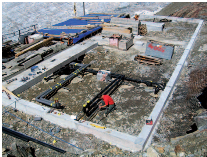
Fig. 43: Soletta continua posta su un basamento roccioso come fondazione di un rifugio alpino (foto: Architetti Ruch, Meiringen).
