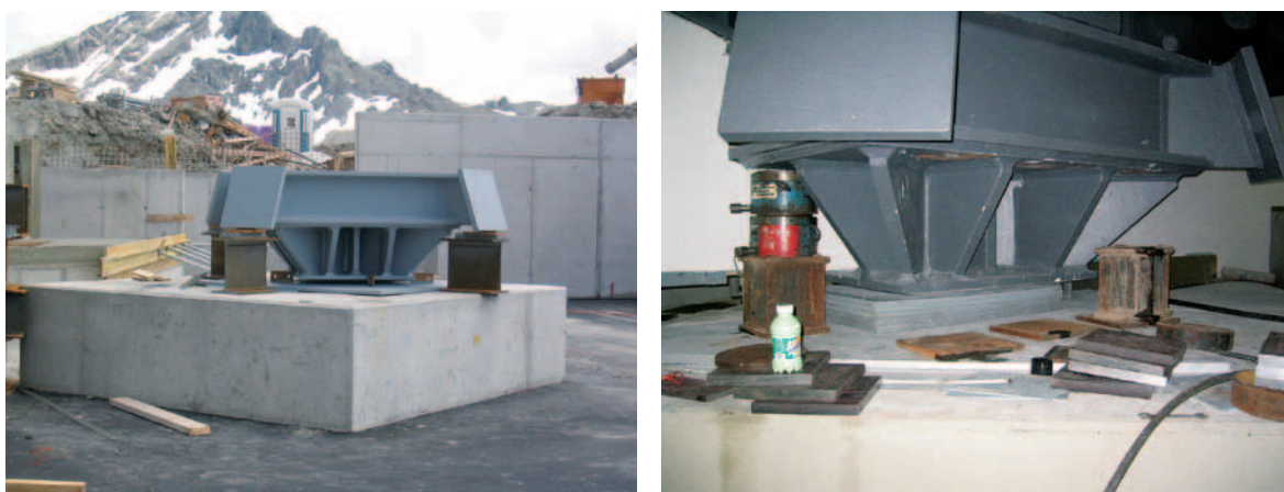
Fig. 48: (a sinistra) Sistema di appoggio tripode di una costruzione in acciaio su un plinto isolato di calcestruzzo; (a destra) correzione di un cedimento per mezzo di una pressa idraulica e posa di lastre in acciaio (foto: Markus Walser, Ischgl).
