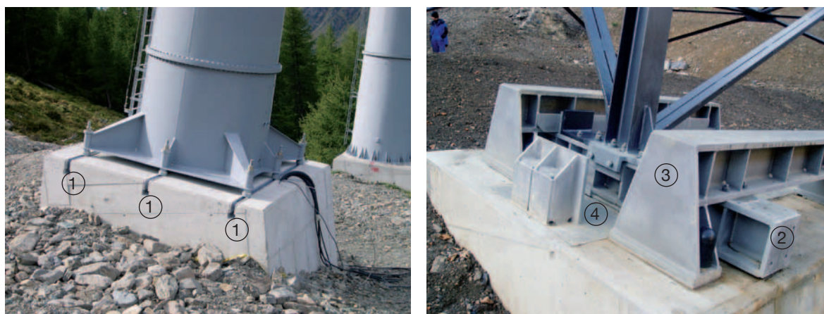
Fig. 47: Due varianti di costruzioni di piloni traslabili, (a sinistra) binari in acciaio, (a destra) lastre di acciaio (foto: Ufficio federale dei trasporti, UFT, Berna).
