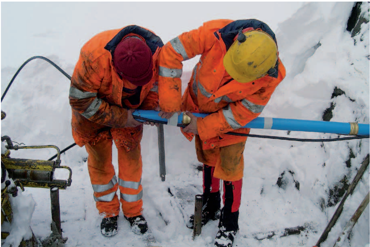
Fig. 36: La squadra di perforazione unisce e rende impermeabile un tubo Inkrex durante l'installazione nel foro di sondaggio. Un tubo destinato a iniettare la malta nel foro di sondaggio è installato parallelamente al tubo Inkrex.
