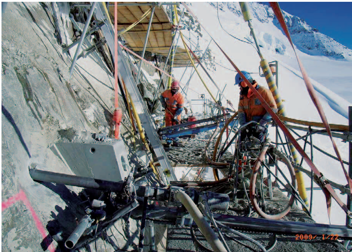
Fig. 38: Travaux d'ancrage dans la roche afin de protéger la sortie d'une galerie contre les chutes de pierres (photo: Gasser, Lungern).
