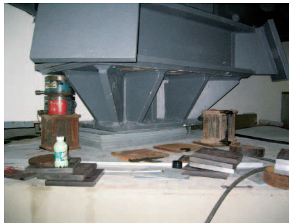
Fig. 48: (à gauche) Système d'appui tripode d'une construction en acier sur une semelle isolée en béton; (à droite) correction d'un tassement à l'aide d'une presse hydraulique et pose de plaques en acier (photos: Markus Walser, Ischgl).
