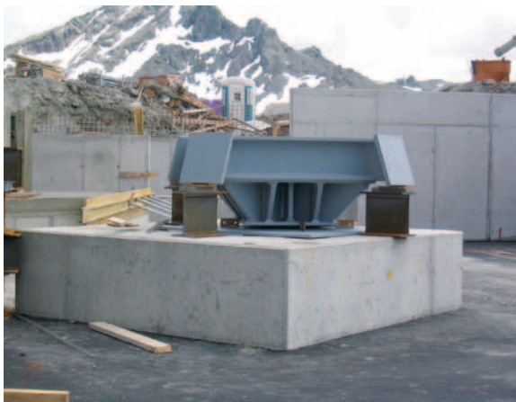
Fig. 48: (à gauche) Système d'appui tripode d'une construction en acier sur une semelle isolée en béton; (à droite) correction d'un tassement à l'aide d'une presse hydraulique et pose de plaques en acier (photos: Markus Walser, Ischgl).
