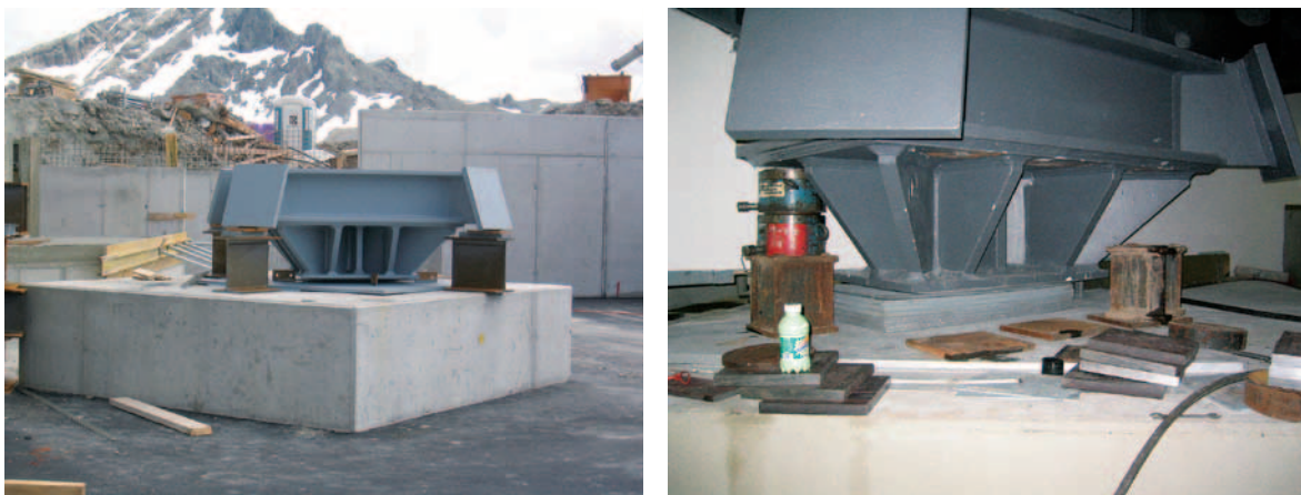
Abb. 48: (Links) Punktlager einer Stahlkonstruktion auf einem Betoneinzelfundament, (rechts) Setzungskorrektur durch eine hydraulische Presse und Einlegen von Stahlplatten (Fotos Markus Walser, Ischgl).
