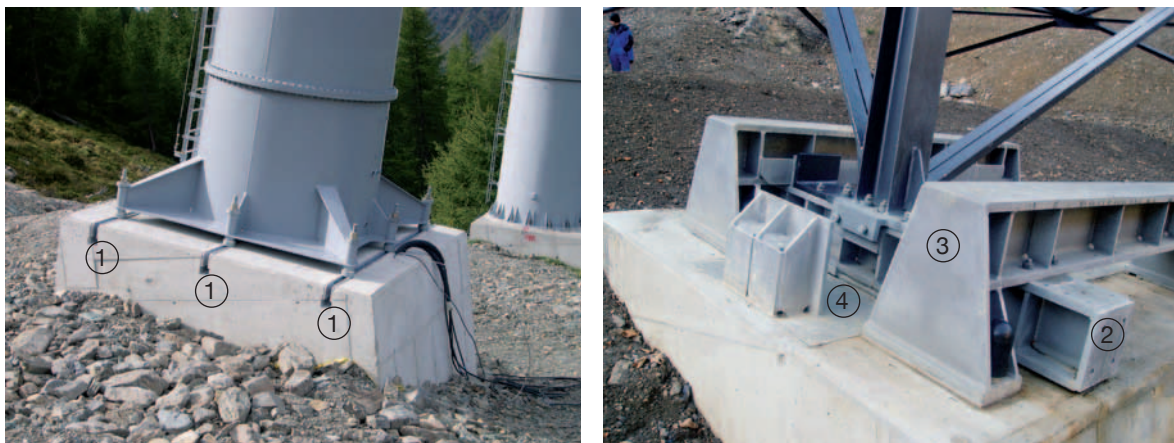
Abb. 47: Zwei Ausführungsvarianten von querverschiebbaren Seilbahnstützen, (links) Stahlschienen, (rechts) Stahlplatten (Foto Bundesamt für Verkehr, BAV, Bern).
