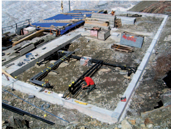
Abb. 43: Streifenfundation einer Berghütte auf felsigem Baugrund (Foto Ruch Architekten, Meiringen).
