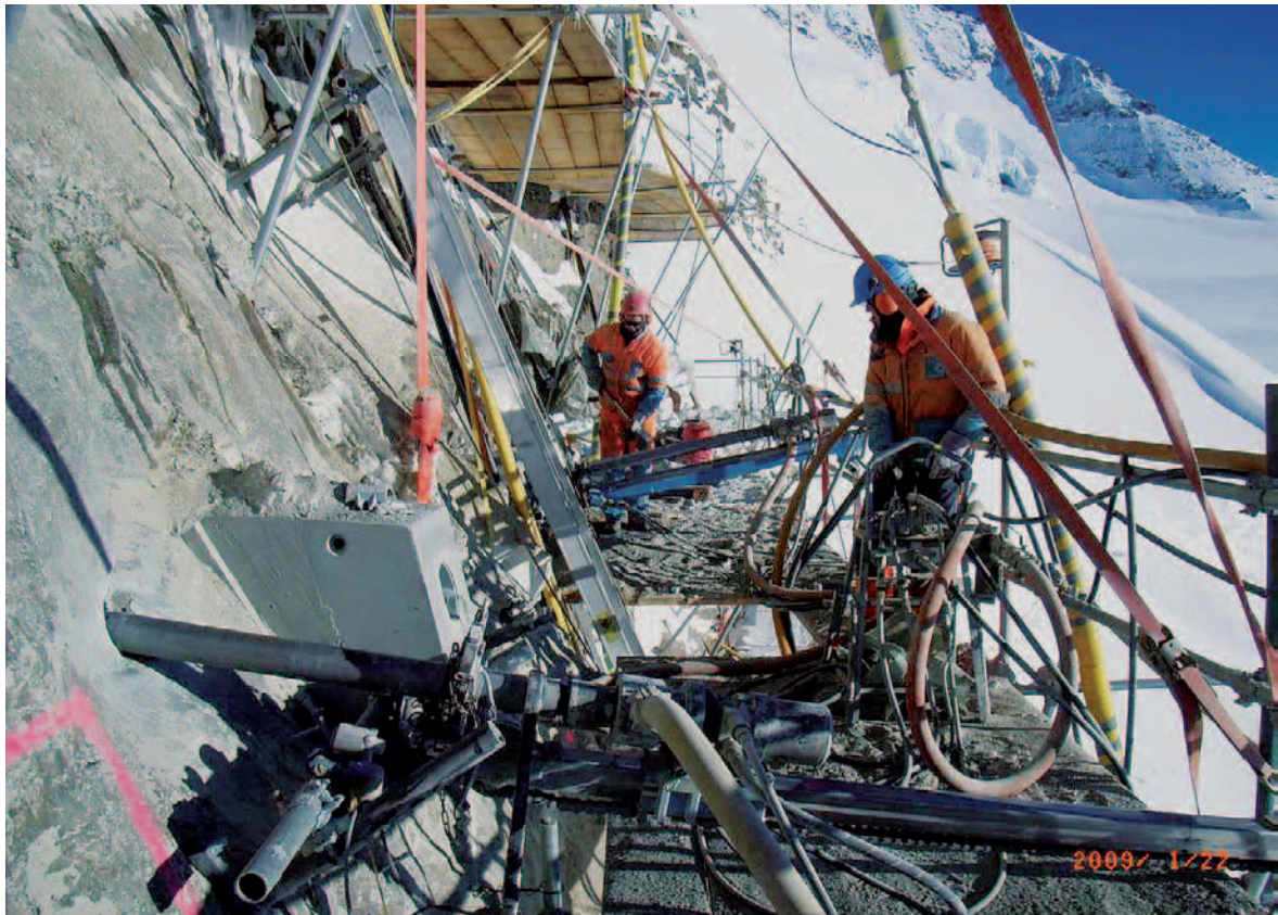
Abb. 38: Felsverankerungsarbeiten zur Sicherung eines Stollenausgangs gegen Steinschlag (Foto Gasser, Lungern).
