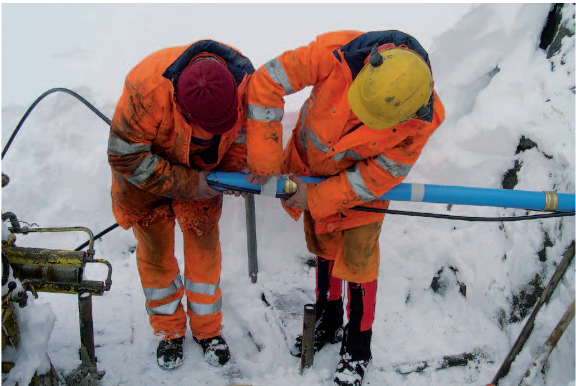
Abb. 36: Ein Inkrexrohr wird von einer Bohrmannschaft während der Installation im Bohrloch zusammengeschweisst und wasserdicht gemacht. Parallel zum Inkrexrohr wird ein Schlauch zur Injizierung des Mörtels in das Bohrloch eingeführt.
