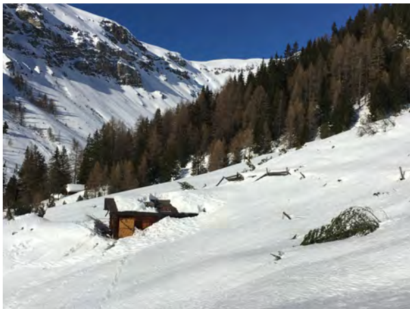
Abbildung 172: Lawinenschäden auf der Bärentaler Alp (Foto: SLF/C. Pielmeier, 24.02.2019).
