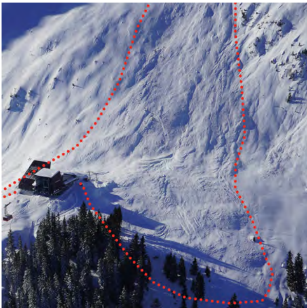
Abbildung 168: Lawine am Gotschnagrät, welche die Mittelstation der Gotschnabahn traf und leicht beschädigte (Foto: SLF/L. Dürr, 16.01.2019).
