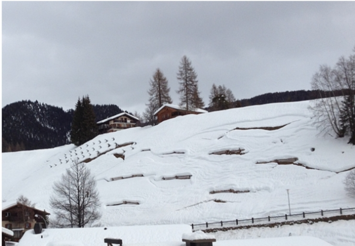
Abb. 5: Schneegleiten kann durch Gleitschneeverbauungen wie Dreibeinböcke oder Stützwerke verhindert werden. In der vorliegenden Situation sind in den verbauten Gebieten keine Gleitschneelawinen angebrochen (Wiesen, Januar 2012; Photo SLF/S. Margreth)
