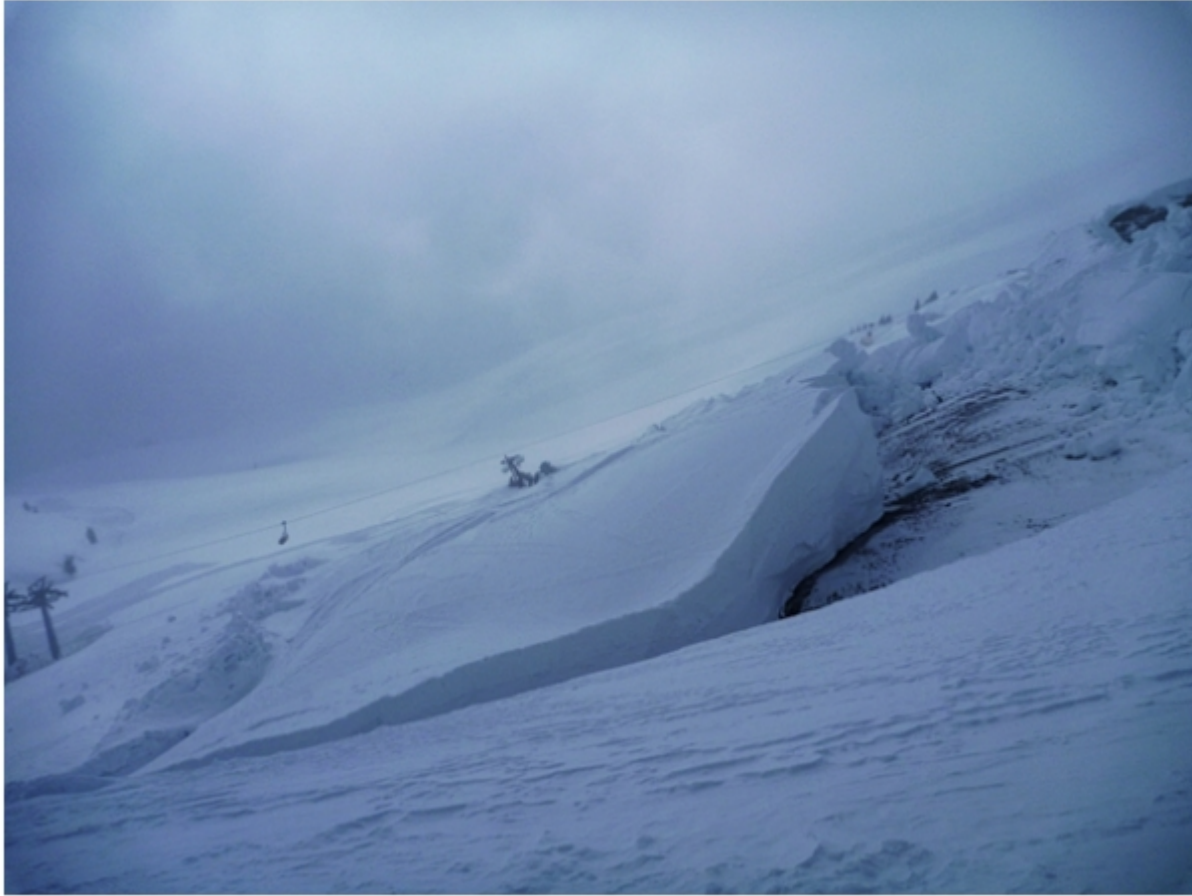
Abb. 4: Ein Bauwerk wie z.B. eine Seilbahnstütze, die sich im Einflussbereich der gleitenden Schneedecke befindet, wird durch sehr grosse Schneedruckkräfte belastet. Bei der Sesselbahn Lungern – Schönbühl wurde dadurch eine Stütze umgedrückt. Der resultierende Schneedruck dürfte mehr als 100 Tonnen betragen haben. Die bis zu 8 m mächtige Schneetafel hat sich um rund 25 m in Talrichtung verschoben (7. Februar 2012; Photo SLF/S. Margreth)
